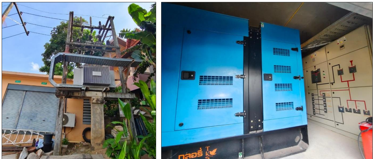
รูปที่ 3-14 หม้อแปลงไฟฟ้า ห้องระบบไฟฟ้า และระบบไฟฟ้าสำรอง
