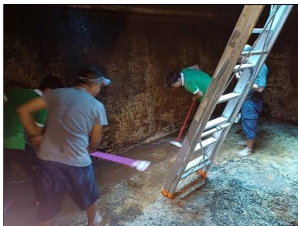
รูปที่ 3-8 บ่อเก็บน้ำใช้ ระบบปรับปรุงคุณภาพน้ำใช้ และการล้างทำความสะอาดบ่อเก็บน้ำใช้ของโครงการ
