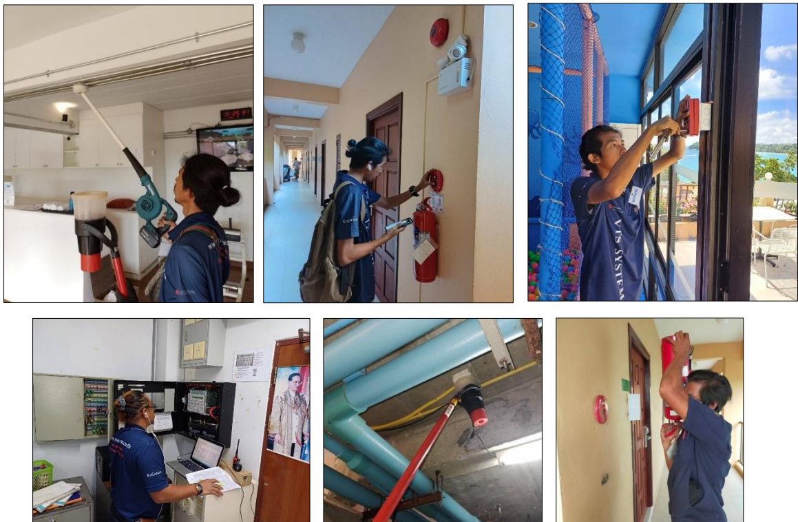
รูปที่ 3-32 การตรวจสอบระบบป้องกันอัคคีภัย และระบบเตือนภัย
